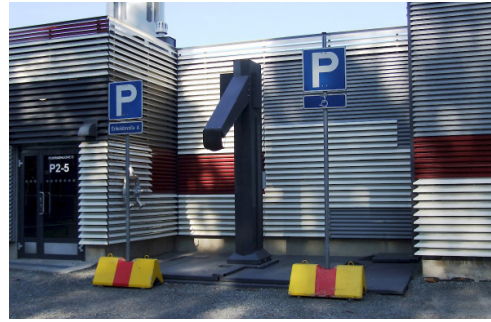
HABA silo de arena soterrado
