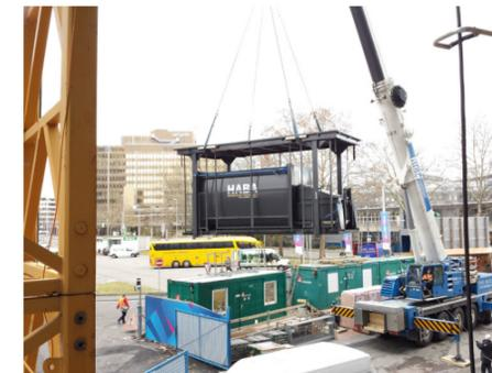
El montaje del sistema dura solo 3-4 horas colocado sobre la cámara de obra soterrada ya preparada.
